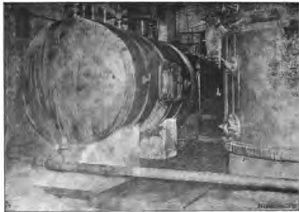
Vue du stérilisateur avant l'aplatissement.
